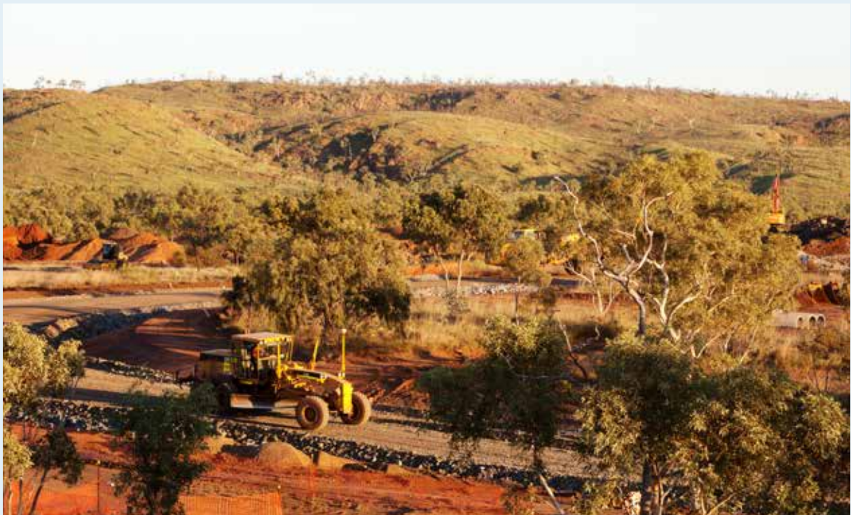
Dugald River矿区道路施工
