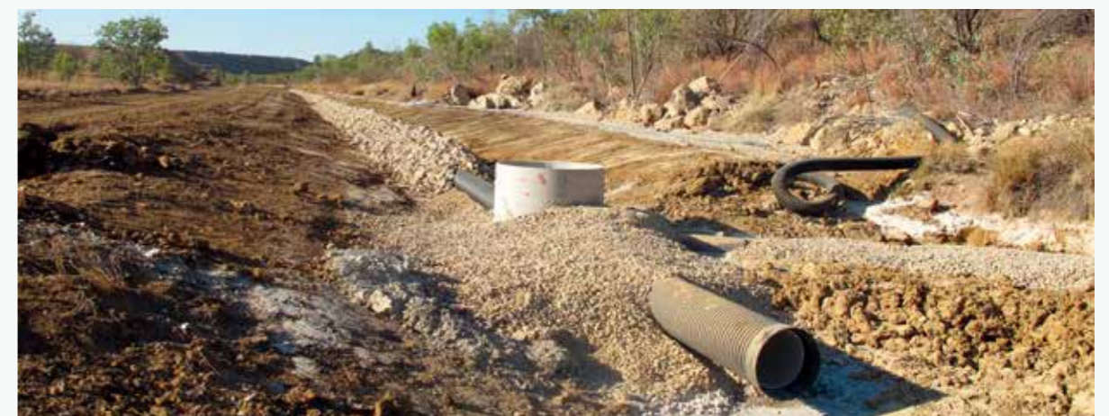
建设中的被动 AMD 处理系统
