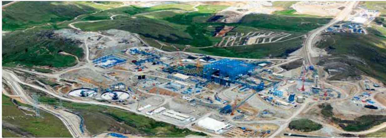
2014 年进入最后建设阶段的 Las Bambas 项目
