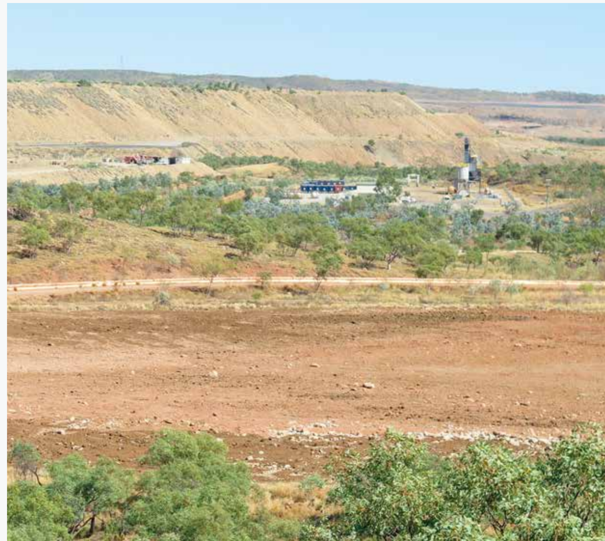
对过去使用的尾矿储存设备进行完最后的清理和复原后 (2014 年 8 月)
