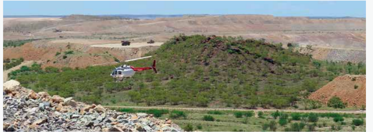
依据 Century 矿山的环境复原计划，利用直升机将本地树木和灌木种子播撒在废矿堆上
