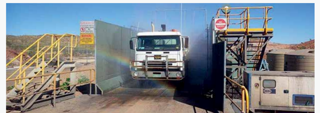
在 Century 矿山设立了一个卡车清洗站，用于清除车辆上的有害铅尘。
