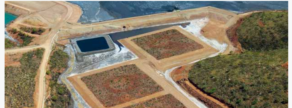
尾矿密闭试验 (2014 年 8 月)
